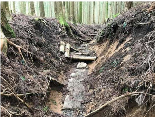
<設置中（土のうは残置）>
