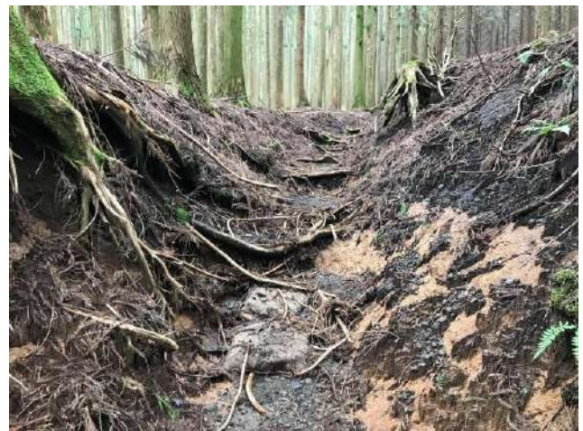
<設置中（土のうは残置）>
