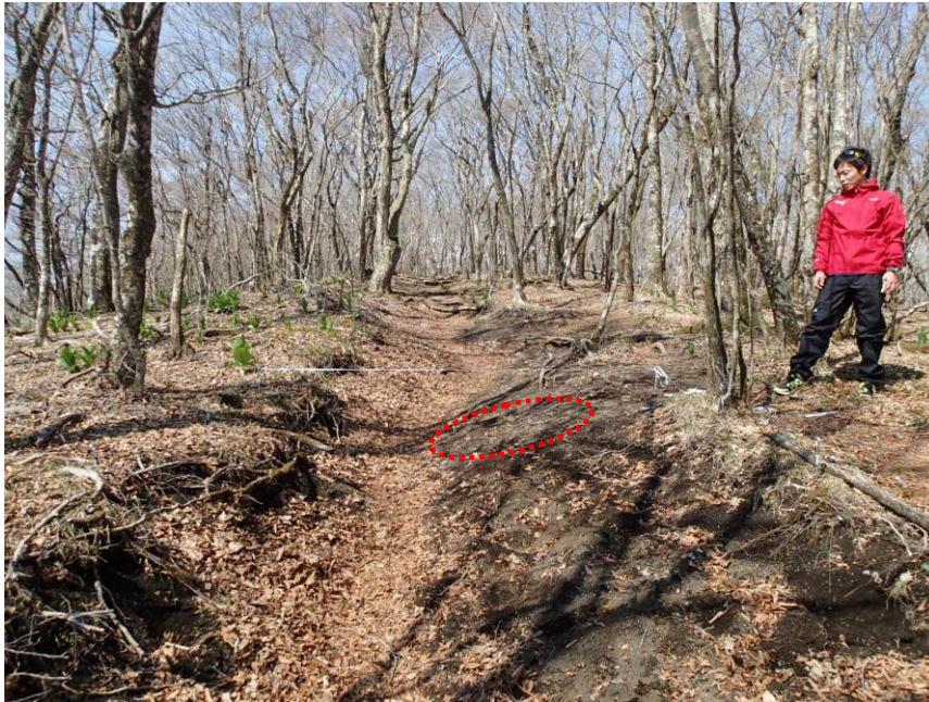
測線 2 : 人が立っている側の緩やかな斜面の一部が崩落したと思われる (楕円破線部分)
