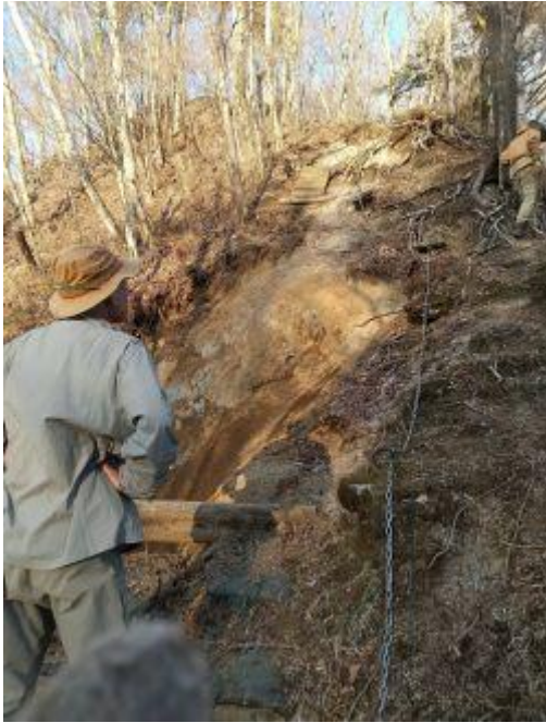
崩落現場①
